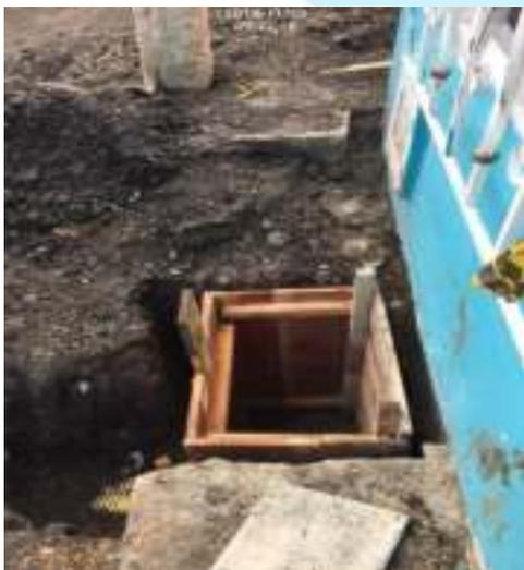
Formaletas para fundición cajas de inspección
