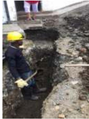
Excavación manual para acometida
