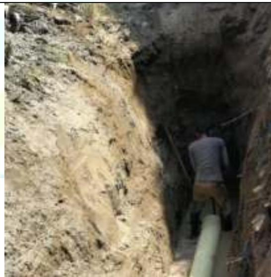
SE PUEDE OBSERVAR LAS PROFUNDIDADES QUE SE ALCANZAN EN INSTALACION DE LAS REDES DE ALCANTARILLADO
