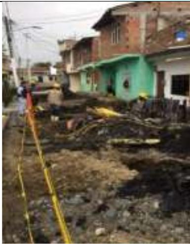
Excavaciones manuales para la inst, acometidas-
