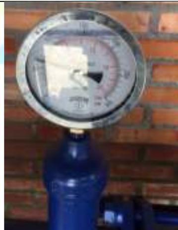
Manómetro con la presión en la tubería
